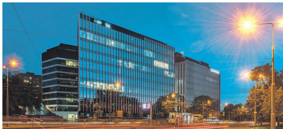
► PIONIER: Szwedzki deweloper Skanska zamierza wykorzystywać ogniwa perowskitowe w budownictwie komercyjnym. Jako pierwszy deweloper na świecie wraz z Saule Technologies rozpoczął testowanie paneli słonecznych zainstalowanych na fasadzie warszawskiego biurowca Spark. [FOT. ARČ]
